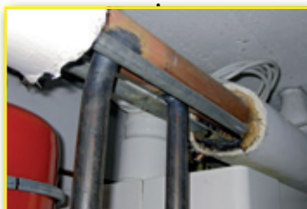
Calorifugeage de tuyaux
