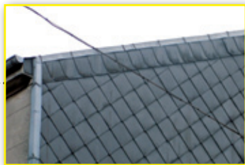
Bardage de façade
